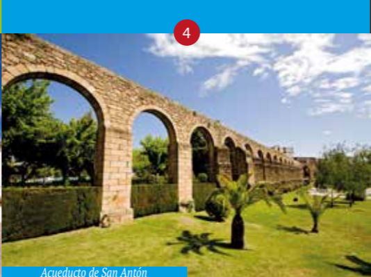
Acueducto de San Antón
